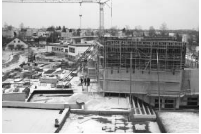
Ein Blick auf die Baustelle am 28. Februar
