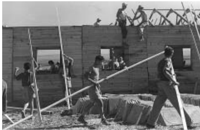
Bauarbeiten in einem Kibbutz 1945
