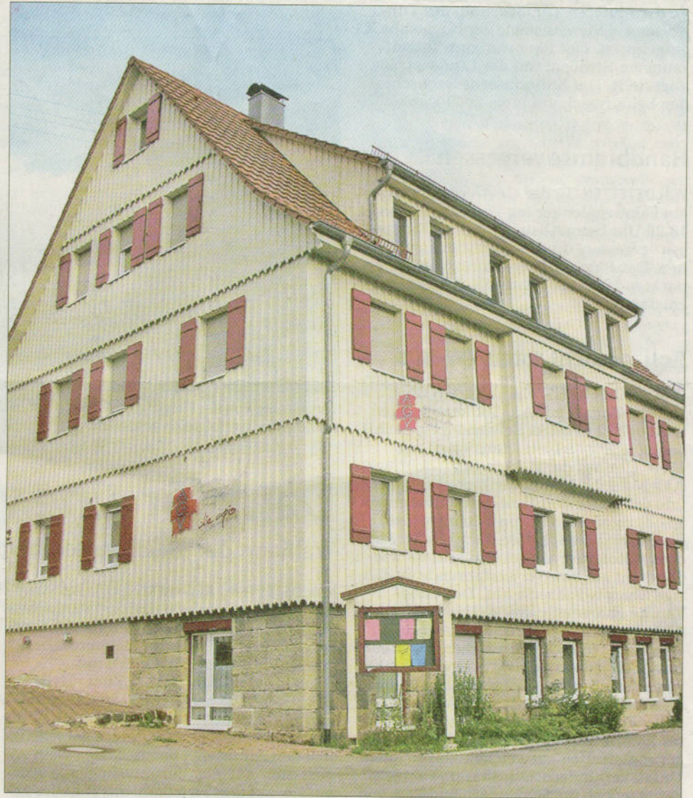
Das repräsentative, liebevoll und stilgerecht renovierte Gebäude zwischen Hagerwald- und Hüttenbühlsee ist das Gemeindezentrum der Altpietisten im Raum Alfdorf und Gschwend. Foto: gbr
